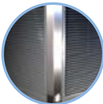
Estructura anticorrosión de acero inoxidable.
